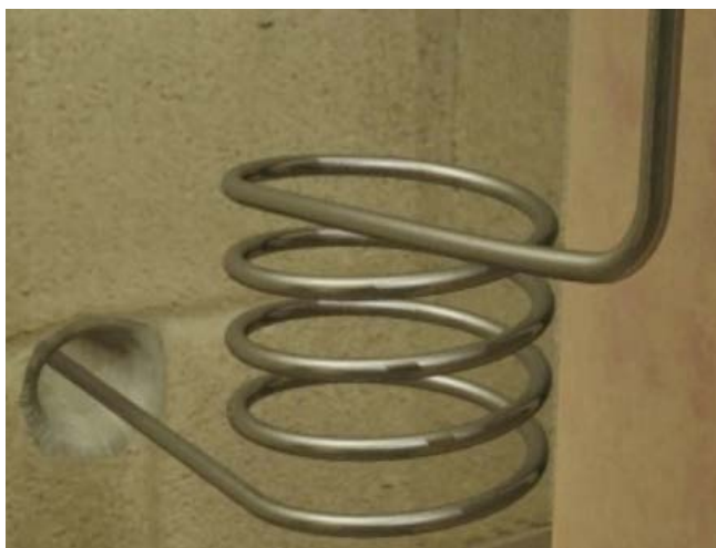
Spirales d'expansion sortant du four
